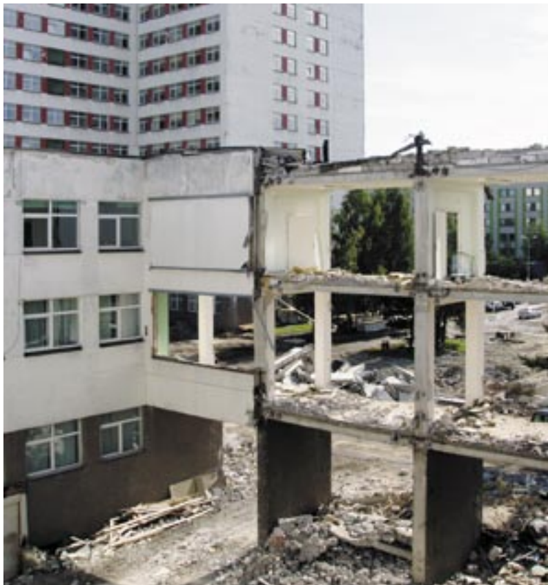
Lammutustööd on ehitustööde esimene faas.
